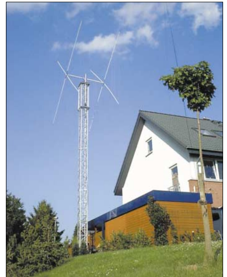
Bild 2: Optimierte Quad auf einem Gittermast bei DL1DTC
