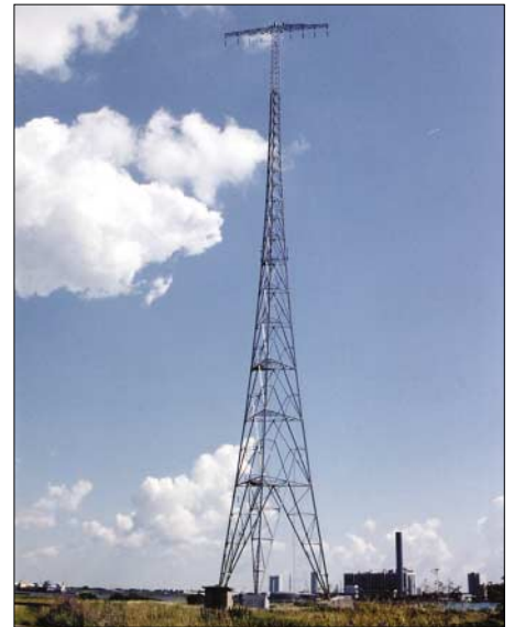
Passiv gespeister Antennenmast der Langwellenantenne
