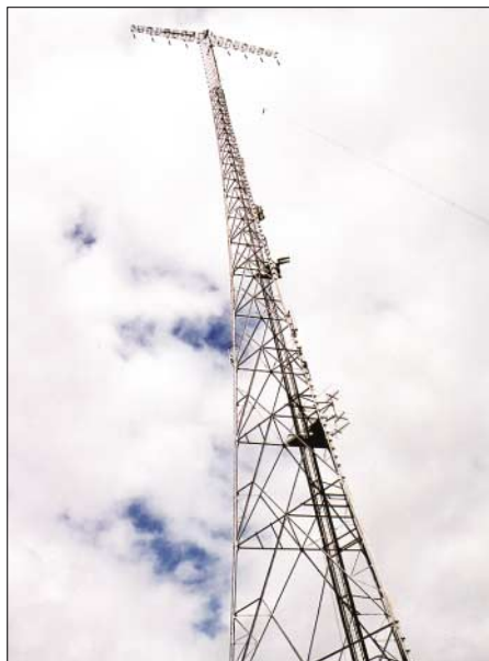
Direkt gespeister Langwellen-Antennenmast nahe des Stationsgebäudes
